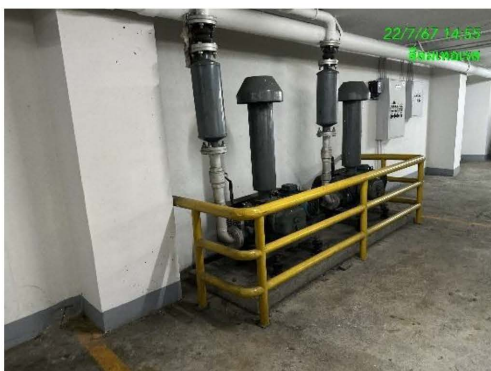
ภาพที่ 2-3 ระบบบำบัดน้ำเสีย การตรวจสอบและดูแลระบบ
