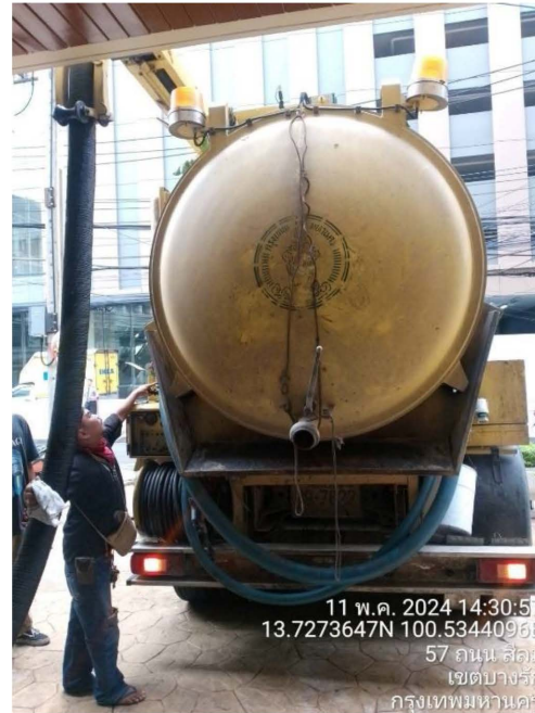
ภาพที่ 2-38 การสูบลากตะกอนออกจากบ่อเกรอะของระบบบำบัดน้ำเสีย
