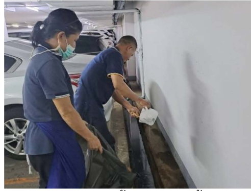
ภาพที่ 2-50 เจ้าหน้าที่ตรวจสอบทำความสะอาดที่ระบายน้ำและบ่อพักน้ำ
