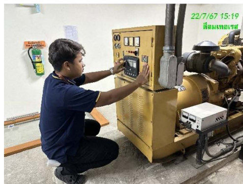
ภาพที่ 2-41 เจ้าหน้าที่ตรวจสอบระบบดับเพลิง ภาพที่ 2-42 เจ้าหน้าที่ตรวจสอบเครื่องกำเนิดไฟฟ้าสำรอง
